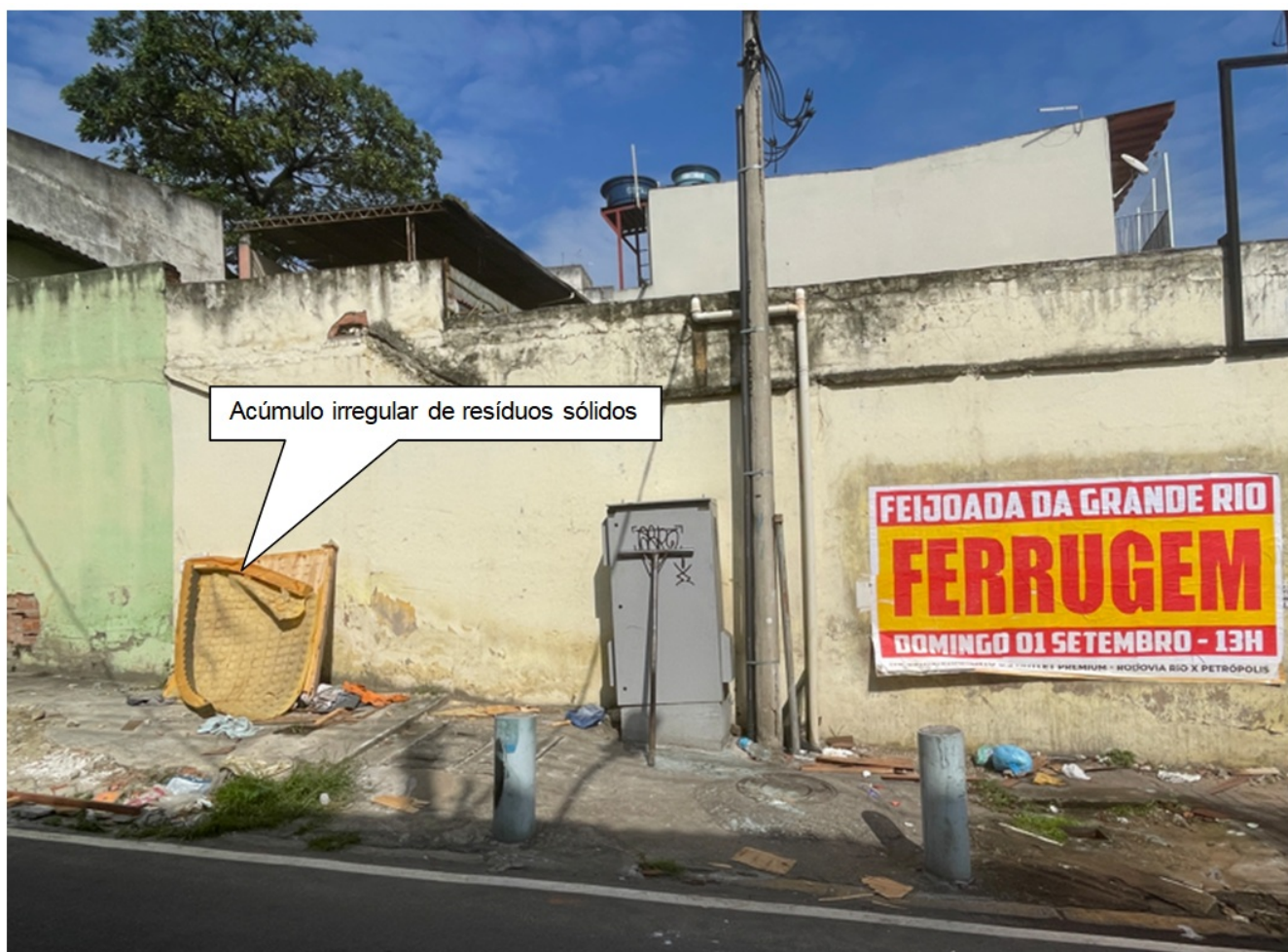
Foto 1 - Localização da EEAT Piaui em calçada de via pública
